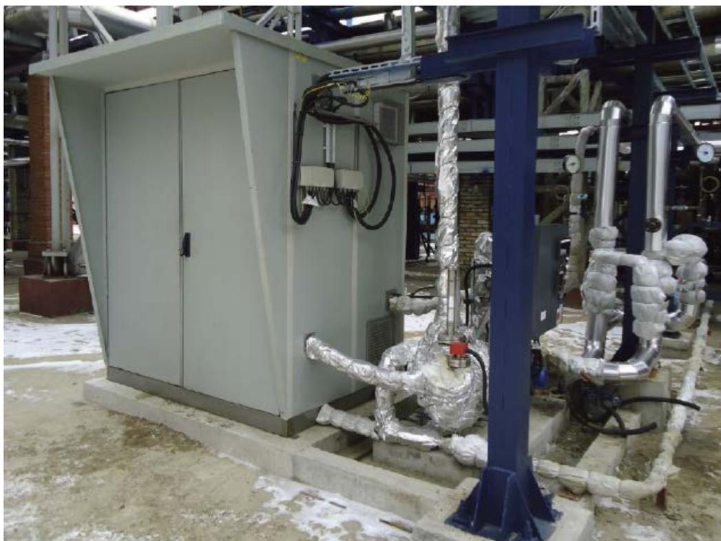
Рисунок 1.6 - Внешний вид приборного шкафа с подводщими трубопроводами «быстрой петли»
