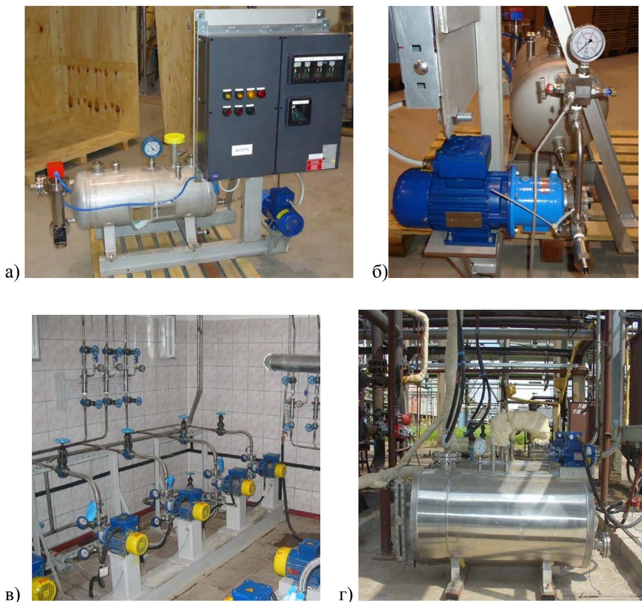
Рисунок 1.2 - Внешний вид систем подачи и возврата пробы: а) емкость возврата объемом 60 л и постом управления насосом возврата; б) насос возврата
