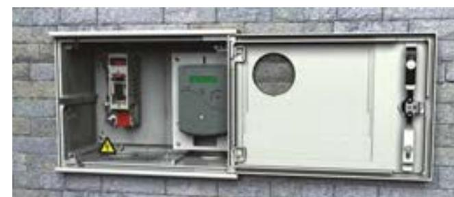
Встраиваемые шкафы или установленные на поверхности стены. Наш APM не деформируются при установке внутри цемента.
